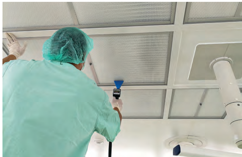
Verificación de la integridad de filtros.
